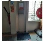
পরিদর্শন Location–Generator room at ground Floor –All incoming and outgoing circuits of LT পর্যবেষ্ণন panels was not clearly and permanently labeled for identifications. ক্যাপ আইটেম ক্যাটাগরি
