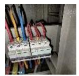
পরিদর্শন Location–Generator room at Ground Floor –Earthing with separate earth pits for LT পর্যবেষ্কণ panels was not provided. ক্যাপ আইটেম ক্যাটাগরি
