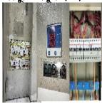
পরিদর্শন || Electric cables do not pass through service shaft or insulated conduits || Connections পর্যবেষ্ক্রণ without lug ক্যাপ আইটেম ক্যাটাগরি
