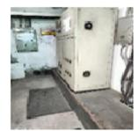
পৰিদৰ্শন Location – Energy Meter, Outside generator room – Energy meter was installed at a প্ৰব্বেষ্ক্ৰণ height of 0.91m ক্যাপ আইটেম ক্যাটাগৰি
