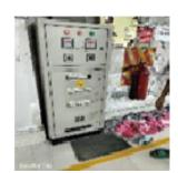
পরিদর্শন Location – Generator room, Shed – 1, LT room, Shed – 1, In front of DB – 1 at 1st floor, পর্যবেষ্ণন Main building – Cable penetration was not covered adequately. ক্যাপ আইটেম ক্যাটাগরি
