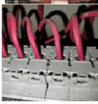
পৰিদৰ্শন Location - Office at Ground Floor, Main building - Power and Telecommunication cables প্ৰবস্থেন were not laid separately. ক্যাপ আইটেম ক্যাটাগৰি
