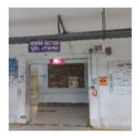
পৰিদৰ্শন Location-Stair exit-1 at ground floor north side Exit signage is not provided on Stair প্ৰব্যেষ্ঠ্য exit-1 at ground floor north side. ক্যাপ আইটেম ক্যাউাগৰি
