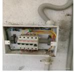
পরিদর্শন Electrical cables are not sized according to capacity of circuit breakers. Location: DB-পর্ববেষ্ষণ 2/ Sewing Section/ Ground floor. ক্যাপ আইটেম ক্যাটাগরি
