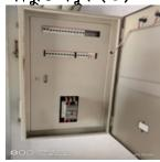
পৰিদৰ্শন Phase separators are not provided between terminals on circuit Breaker. Location: পৰ্শবেষ্ণন MDB/ Finishing Section/ Ground floor. ক্যাপ আইটেম ক্যাটাগনি
