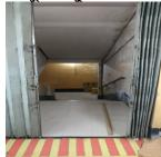
পৰিদৰ্শন Location – All exit doors in egress route The exit doors in the egress route are sliding , পৰ্শবেষ্ষণ collapsible security gate type doors and all doors are lockable. ক্যাপ আইটেম ক্যাটাগৰি
