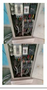
পৰিদৰ্শন | Electric cables do not pass through service shaft or insulated conduits | Connection প্ৰ্ববেষ্ণ্য without lug | Undressed messy wire inside ক্যাপ আইটেম ক্যাটাগনি
