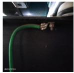
পরিদর্শন Each circuit is not provided with a dedicated earthing. There is no marking to identify পর্যবেষ্কন earthing cable for specified circuit. ক্যাপ আইটেম ক্যাটাগরি
