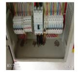
পরিদর্শন Each circuit is not provided with a dedicated neutral. There is no marking to identify পর্ববেষ্ষণ neutral cable for specified circuit. ক্যাপ আইটেম ক্যাটাগরি
