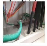
পরিদর্শন Looping of cables at circuit breakers and multiple connections of cables at busbar পর্যবেষ্ণণ terminal and circuit breaker terminal are observed within distribution boards. ক্যাপ আইটেম ক্যাটাগরি
