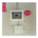
পরিদর্শন The factory has not provision of periodic checking of alarm call point & alarm system পর্যবেষ্ণন with maintaining record properly ক্যাপ আইটেম ক্যাটাগরি
