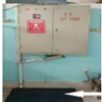
পরিদর্শন |Location-Substation room -Fire extinguisher and smoke detector were not found in পৰ্যবেষ্ণণ substation room. ক্যাপ আইটেম ক্যাটাগরি
