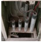
পরিদর্শন Location–Generator room – Only one earthling connection was provided to the পর্ববেষ্ণন generator frame. ক্যাপ আইটেম ক্যাটাগরি
