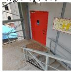
পৰিদৰ্শন Location: All stairways There are 2 nos stairs in the factory building but stairs are not পৰ্শবেষ্ণন provided handrails on both side. ক্যাপ আইটেম ক্যাটাগবি
